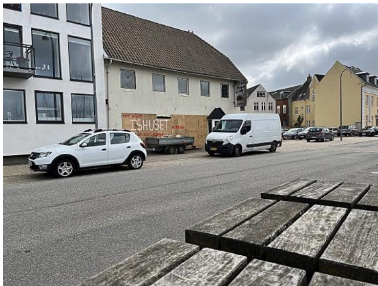
Havnegade 20 - eksisterende forhold
